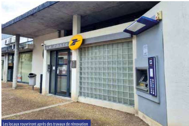
Les locaux rouvriront après des travaux de rénovation
